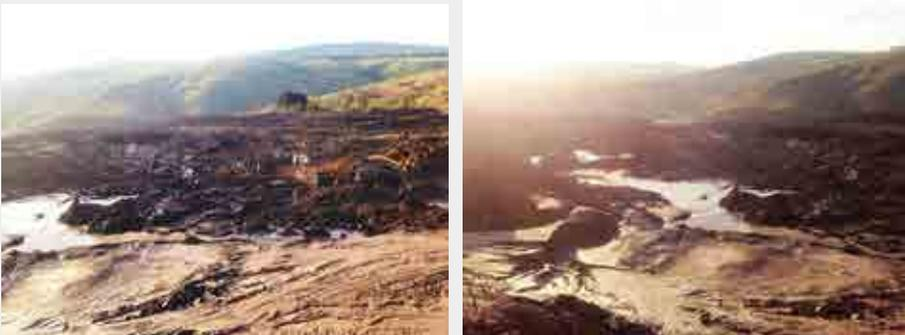
Fotos de ruptura de barragem de rejeito de minério de ferro ocorrida em setembro de 2014 em mineração de ferro no município de Itabirito, MG.
