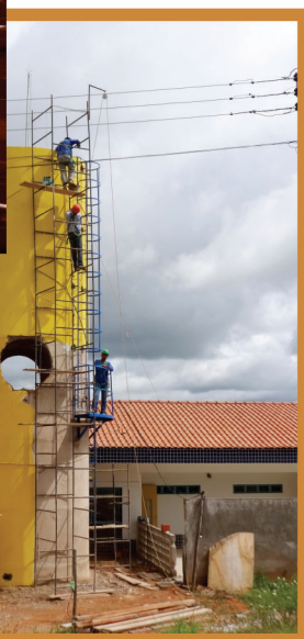
Exemplos de situações de risco de queda de trabalhadores e projeção de materiais em obras de todo o país. Os casos, frequentemente apurados nas obras do país, apresentam andaimes e instalações completamente inseguros e inexistência de proteções coletivas nos locais de trabalho. Fotos registradas por Auditores Fiscais do Trabalho em diferentes estados e regiões do Brasil entre 2012 e 2015
