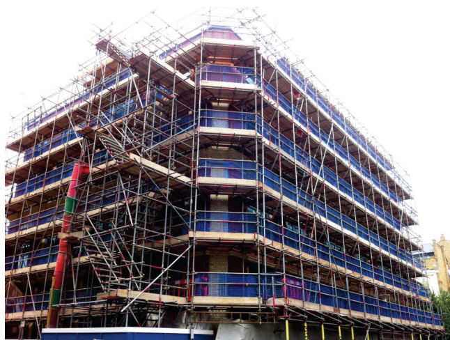
Obra em Londres, junho de 2015 (Bermondsey)
